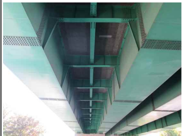
주형 및 바닥판 전경
