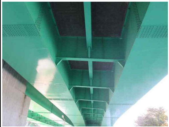
주형 및 바닥판 전경
